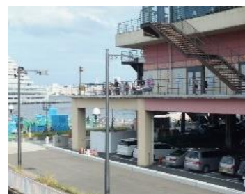
写真28 モザイクのデッキ(1F 駐車場) (デッキ高さ6m、エプロン幅約25m)
