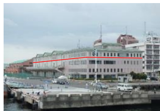
写真 24 清水港マリンターミナルビル(赤線 3F レベル)
