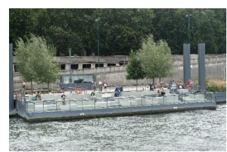
写真 4 第 2 期ウォーターフロント開発 パリ・フローティングガーデン
