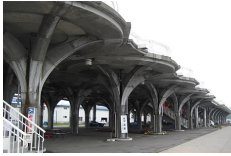
写真13 青苗漁港人工地盤
