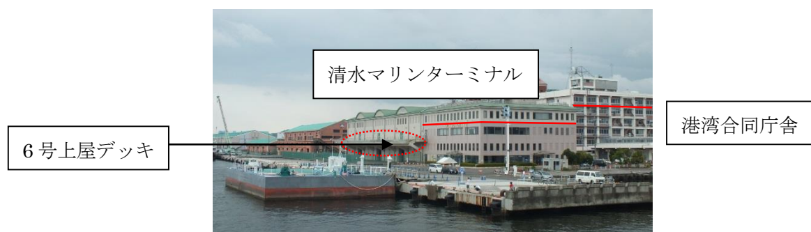
写真12 日の出埠頭清水マリンターミナル(写真中央)と港湾合同庁舎(写真右)の津波避難階
